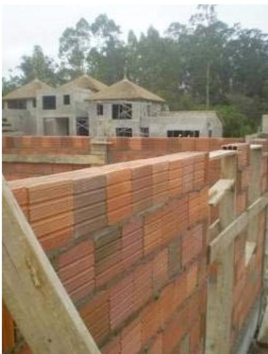
CAJON HIDROFUGO PARA MUROS EN UNIDADES 4 Y 5, ATRÁS UNIDAD 3 CON MUROS A LA ALTURA DEL DINTEL Y MAS AL FONDO, EL SECTOR B.
