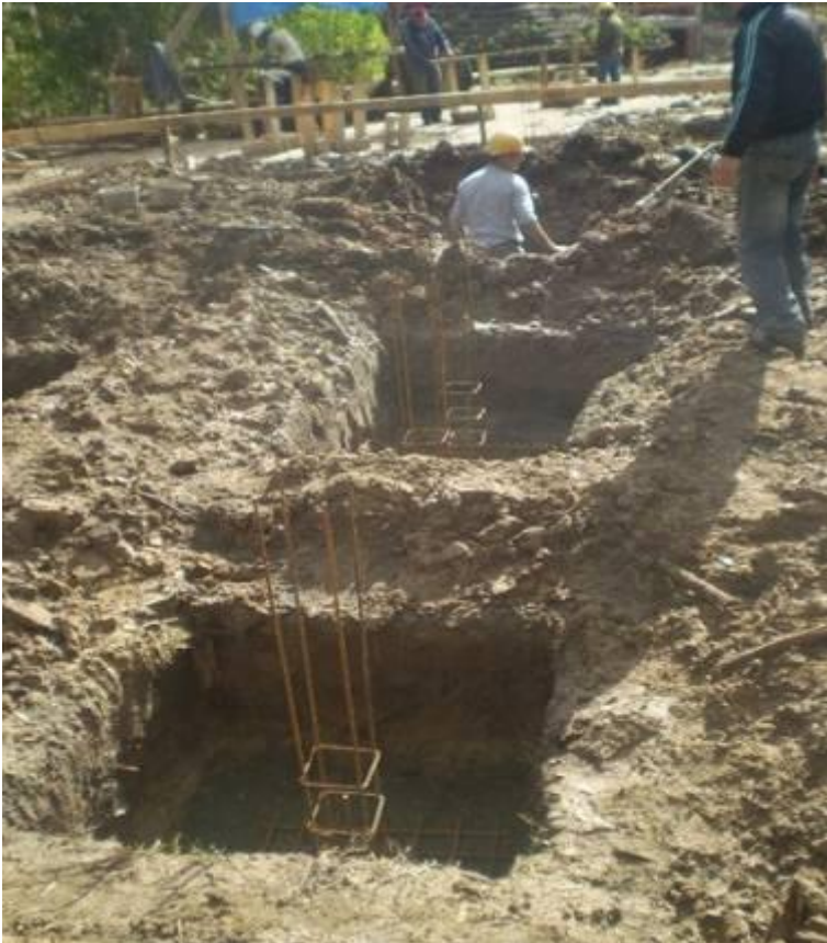
HORMIGON EN BASES DEL SECTOR A
