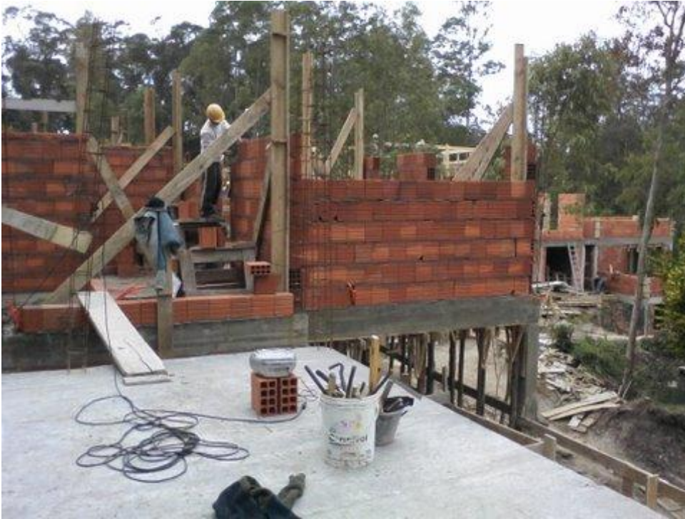
ENCOFRADO PARA ESCALERA EXTERIOR DE LA UNIDAD 16 DEL SECTOR B.
