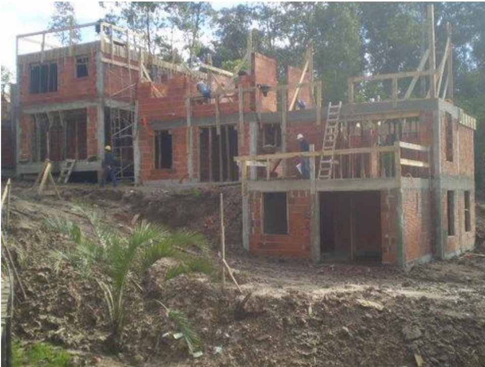
AVANCE DE MAMPOSTERIA EN SECTOR A (UNIDADES 6,7 Y 8)
