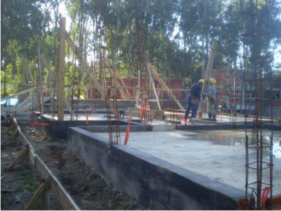
AVANCE DE MAMPOSTERIA EN SECTOR B.
