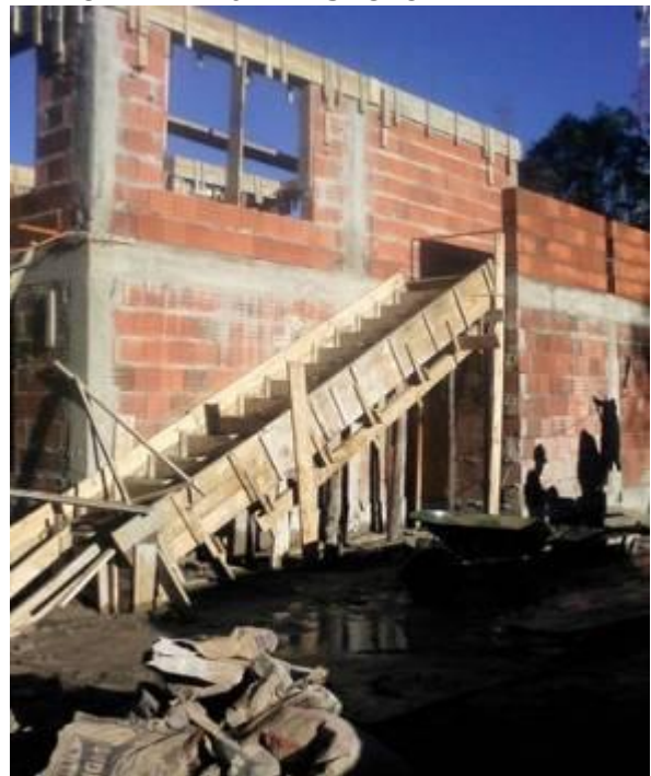
ENCOFRADO PARA ESCALERA EXTERIOR DE LA UNIDAD 16 DEL SECTOR B.
