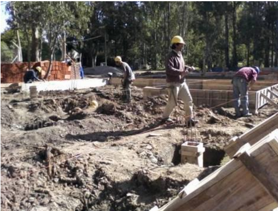
ARMADO DE ENCOFRADOS PARA VIGAS Y LOSAS DE FUNDACION EN SECTOR A
