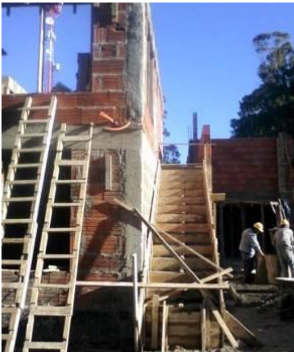
ENCOFRADO PARA ESCALERA EXTERIOR DE LA UNIDAD 16 DEL SECTOR B.
