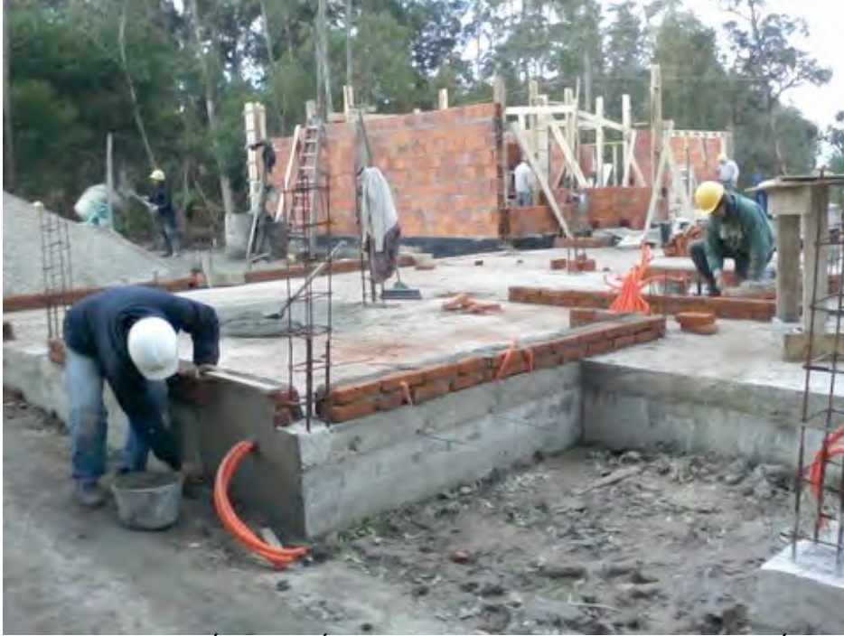
ARMADO DE CAJÓN HIDRÓFUGO EN SECTOR B2 Y MAMPOSTERÍA EN SECTOR B1.
