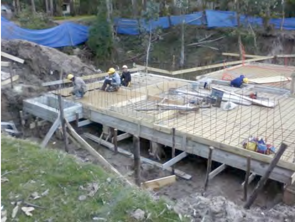
ARMADO DE LOSAS DE FUNDACION EN SECTOR A.
