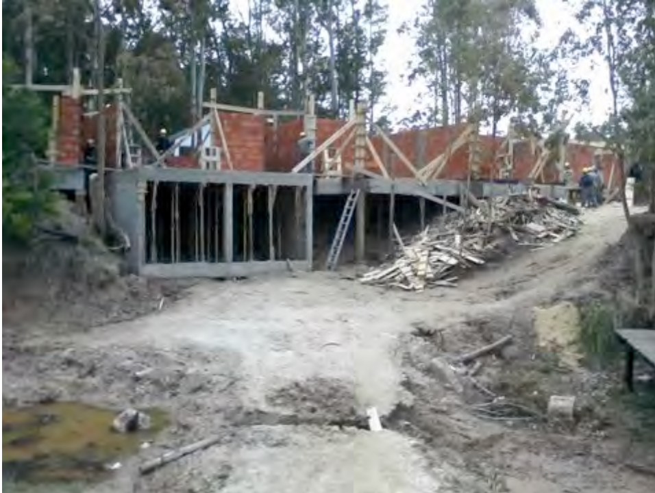
VISTA DESDE EL POZO, MAMPOSTERIA EN SECTOR B2 (UF 11,12,13,14,15)
