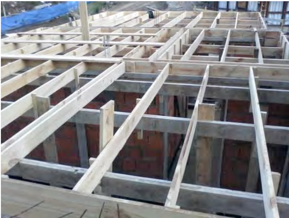
ARMADO DE ENCONFRADO DE LOSAS SOBRE PB EN SECTOR B1 (UF 16,17,18,19)
