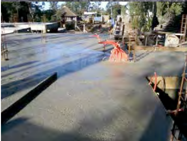
HORMIGONADO DE LOSAS DE FUNDACION EN SECTOR B2.
