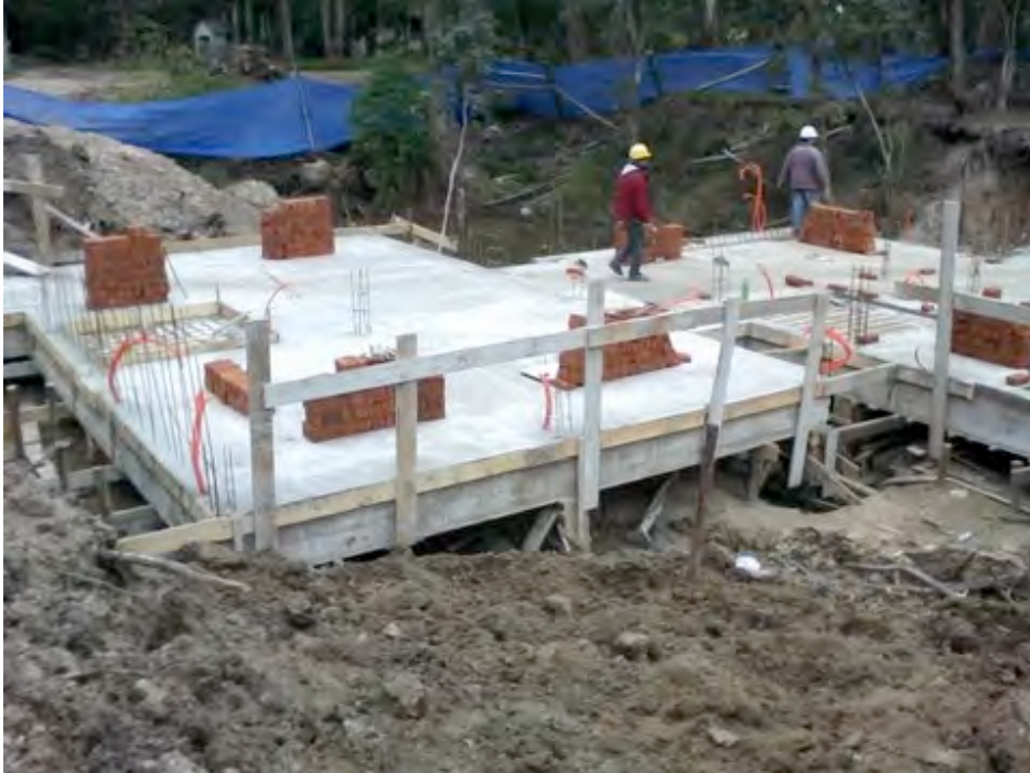
ACOPIO DE LADRILLOS PARA REPLANTEO DE MUROS EN SECTOR A.
