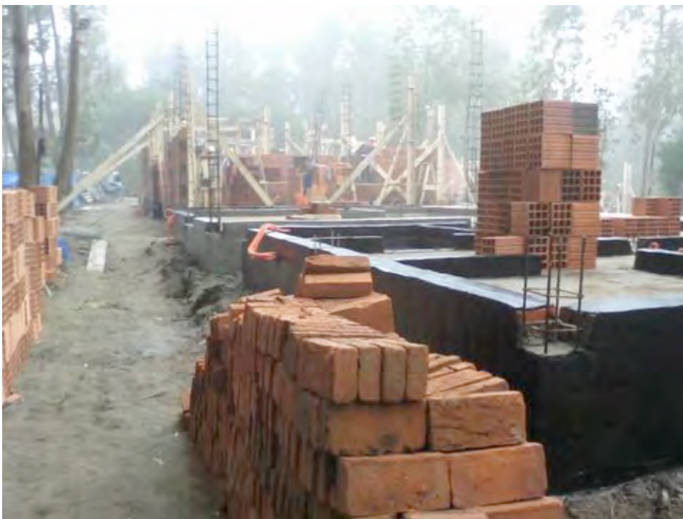
AVANCE DE MAMPOSTERIA EN VIVIENDAS DEL SECTOR B2.
