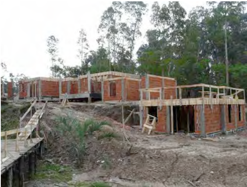
VISTA DE MAMPOSTERIA SECTOR B1 (UF 16,17,18,19)
