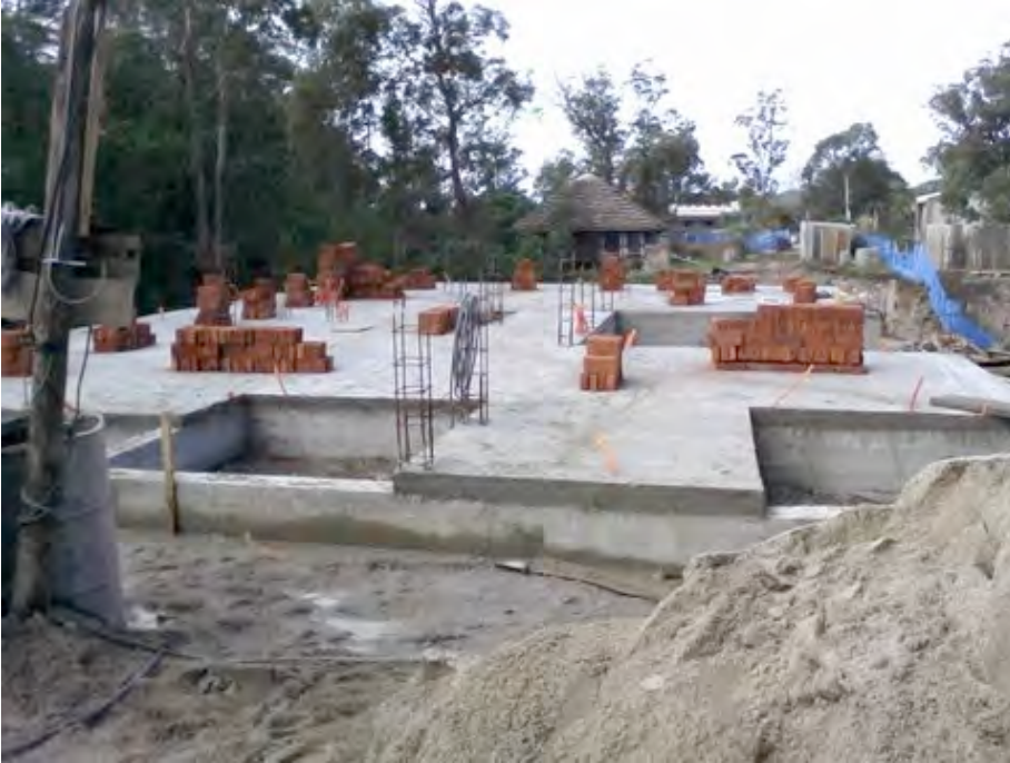
ACOPIO DE LADRILLOS PARA EL REPLANTEO DE MUROS, EN SECTOR B1.
