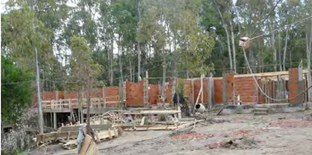
VISTA DE MAMPOSTERIA SECTOR B2 (UF 11,12,13,14,15)
