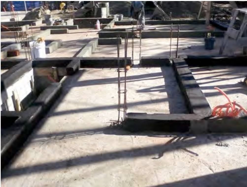
AISLACION HIDRÓFUGA DEL CAJÓN (SECTOR B1).
