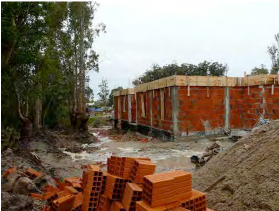
VISTA DE MAMPOSTERIA HASTA EL NIVEL DE LOSA EN SECTOR B1.
