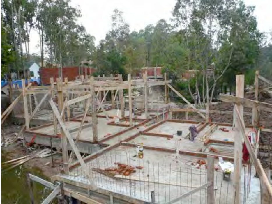
REPLANTEO DE MUROS EN SECTOR A (UF 8,9,10)
