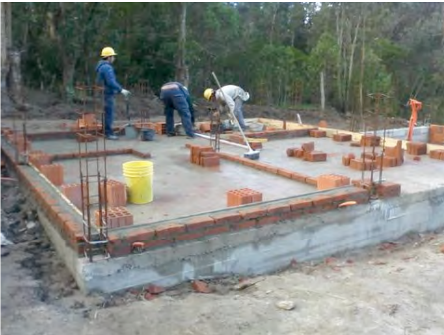
ARMADO DE CAJÓN HIDRÓFUGO, REPLANTEO DE MUROS, EN SECTOR B1.
