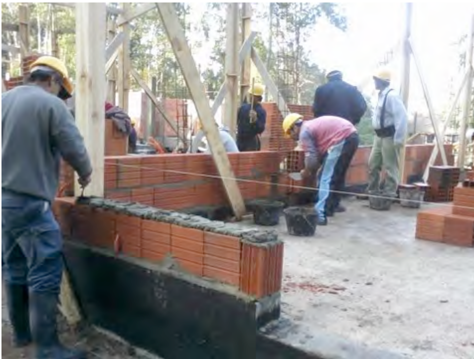
ARRANQUE DE MAMPOSTERÍA EN SECTOR B2.
