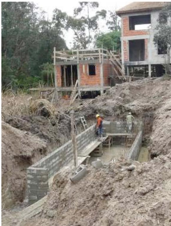
SE CONSTRUYÓ LA CÁMARA PARA LA PLANTA DE TRATAMIENTO DE AGUAS RESIDUALES QUE QUEDARA COMPLETAMENTE ENTERRADA
