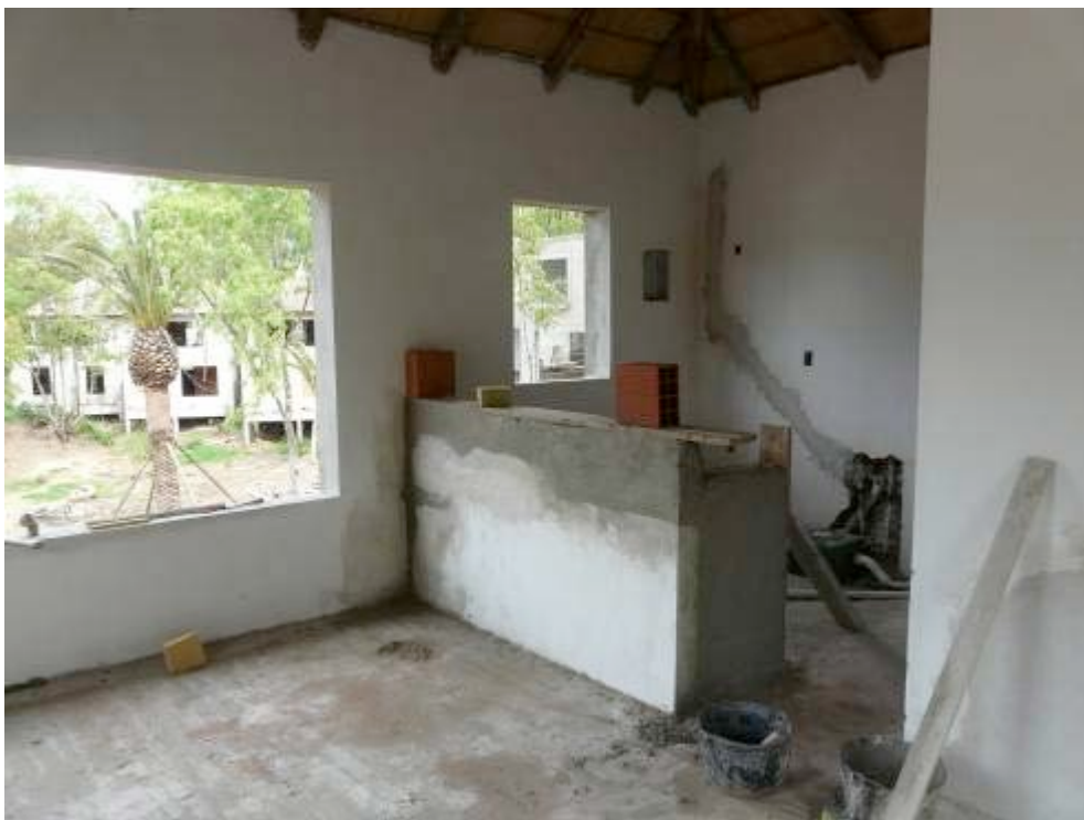
AVANCE DE INSTALACION SANITARIA, REVOQUES, CONTRAPISOS Y BARRAS DE COCINA EN SECTOR B.
