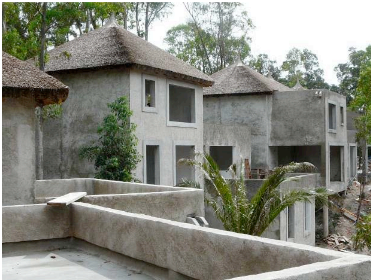
IMPERMEABILIZACION DE TERRAZAS, RECUADROS Y REVOQUES TERMINADOS EN SECTOR B.
