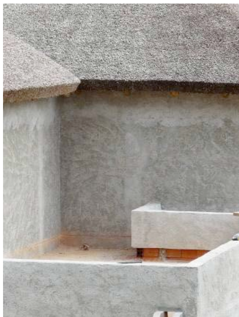
IMPERMEABILIZACION DE TERRAZAS, RECUADROS Y REVOQUES TERMINADOS EN SECTOR B.
