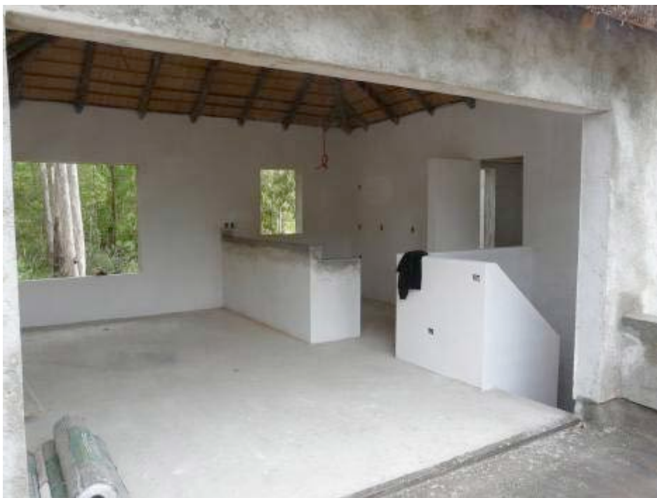
AVANCE DE INSTALACION SANITARIA, REVOQUES, CONTRAPISOS Y BARRAS DE COCINA EN SECTOR B.
