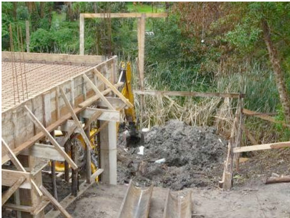
AVANCE DE ESTRUCTURA DEL SECTOR C: ARMADO DE PILARES, VIGAS Y LOSAS DE FUNDACION
