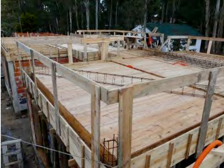
ARMADO DE LOSAS EN SECTOR B.
