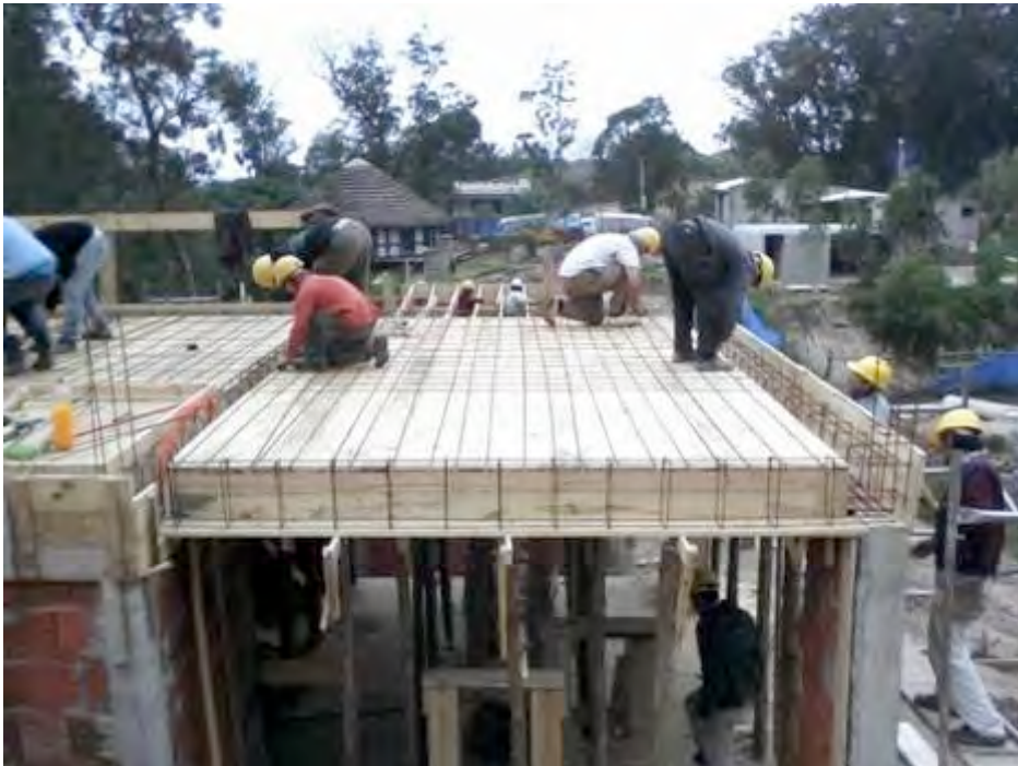
ARMADO DE LOSAS EN SECTOR B.
