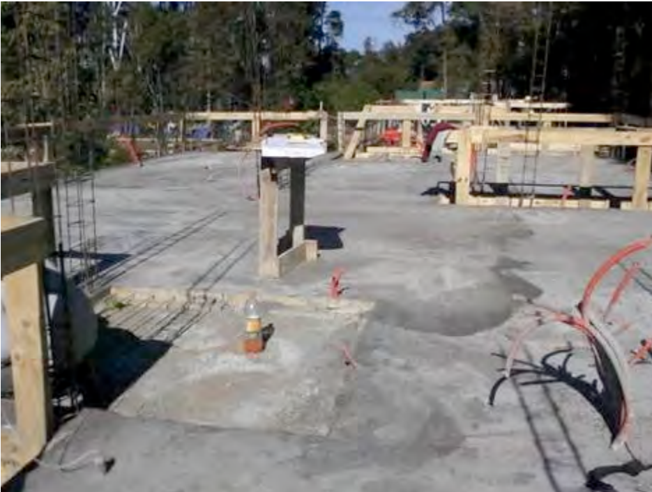
HORMIGON EN LOSAS SOBRE PLANTA BAJA EN SECTOR B.
