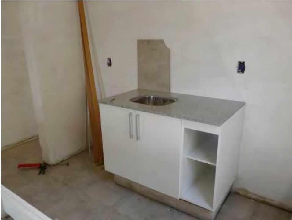
MESADA Y PILETA EN COCINA.
