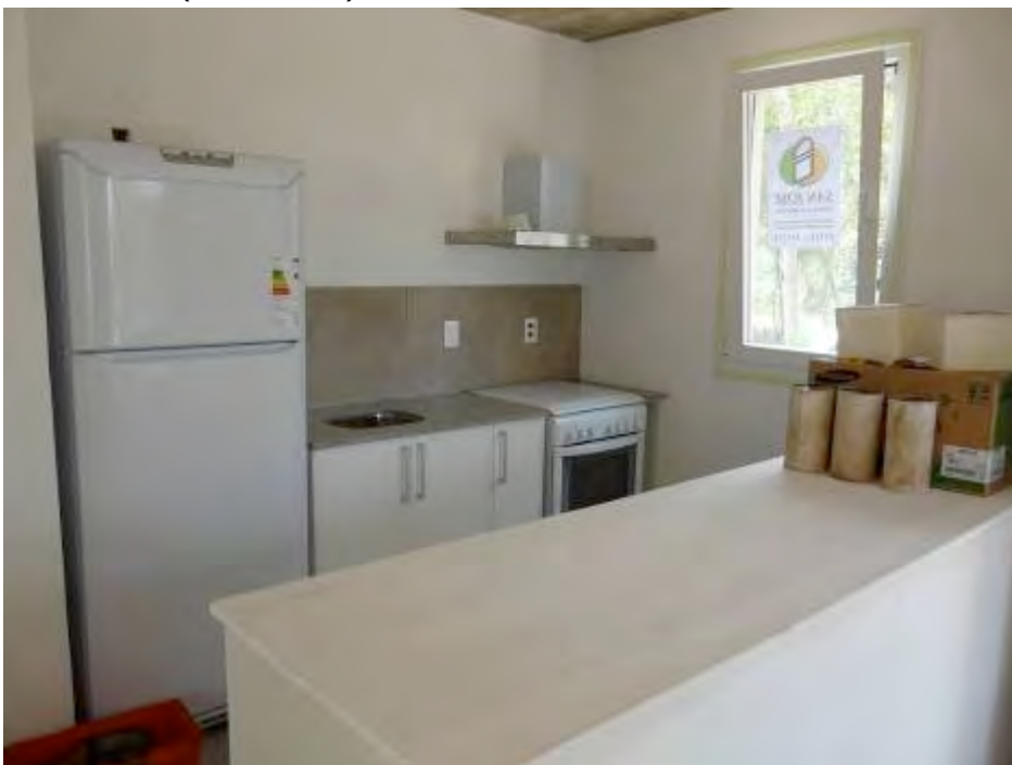
COCINA EQUIPADA. ABERTURAS DE PVC YA COLOCADAS. CAMPANA DE EXTRACCION COLOCADA (OPCIONAL)
